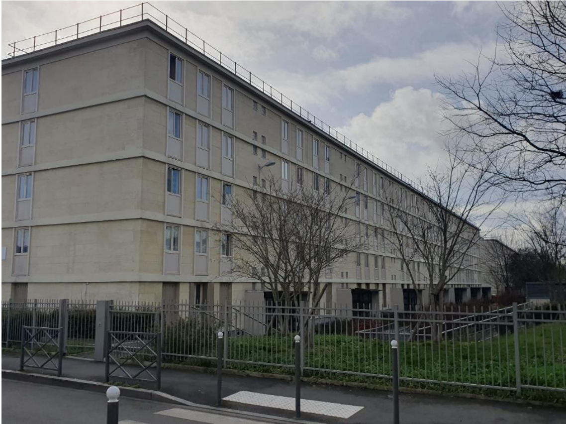
Les premiers immeubles de Sarcelles, construits en pierre de taille. Photo Mémoires de Meyrin
